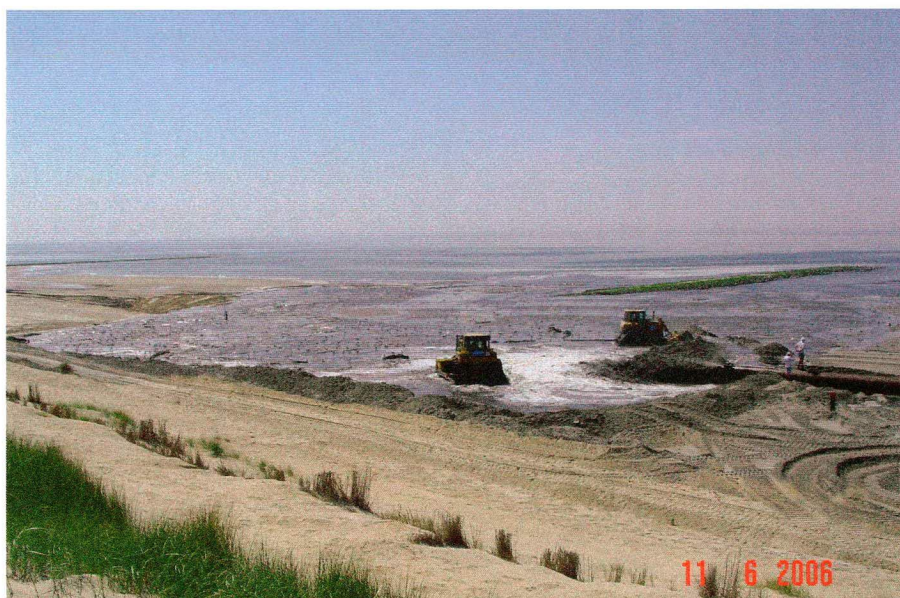
Figuur 4.3 Overzicht werkzaamheden op strand (strandsuppletie Texel)
