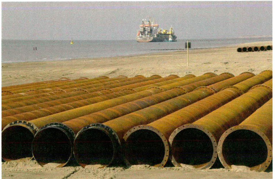
Figuur 5.3 Buizen op het strand van Walcheren (strandsuppletie Walcheren)
