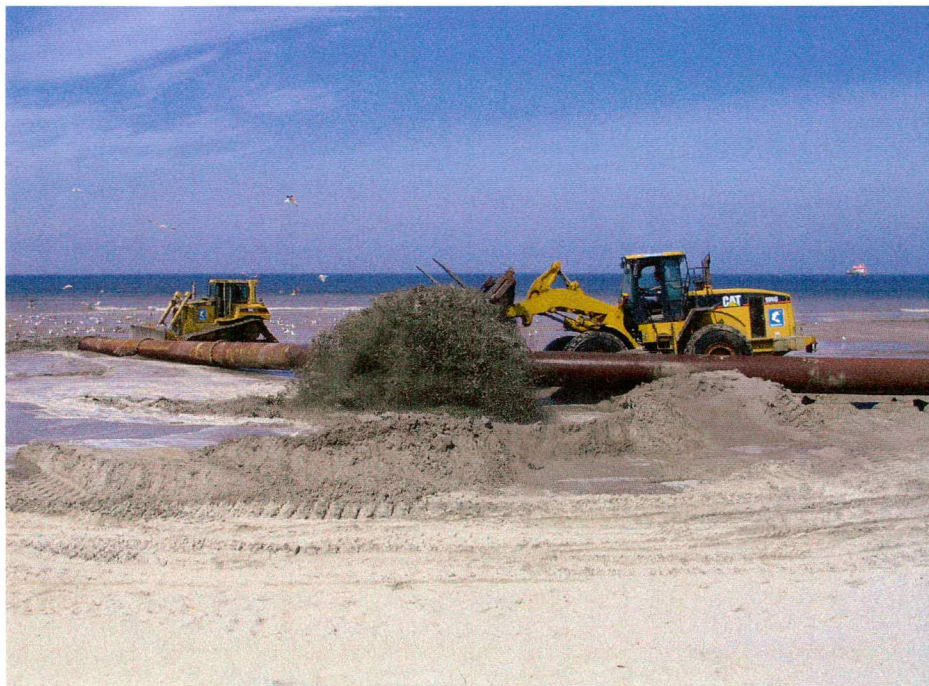
Figuur 6.1 Koppelen van pijpen (strandsuppletie Ameland)
