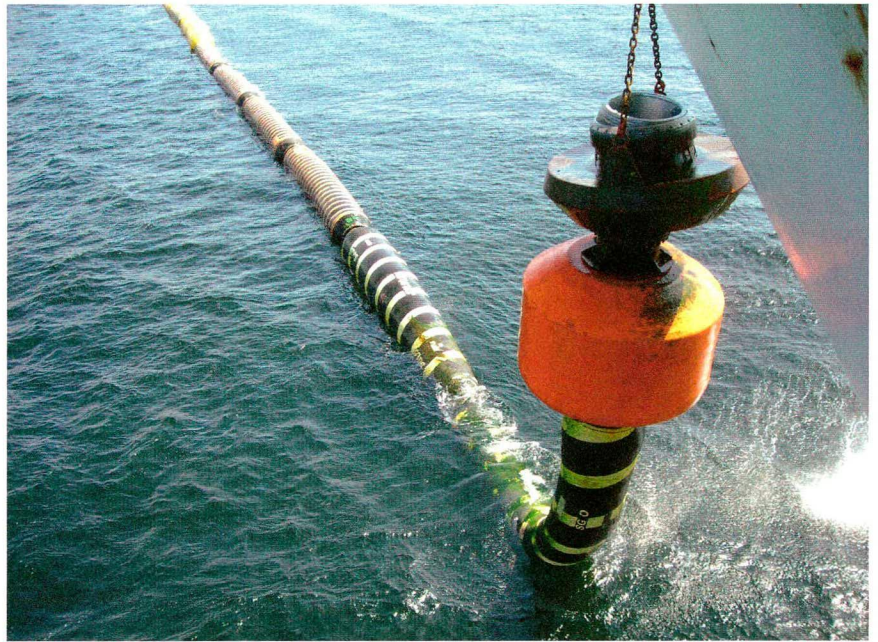
Figuur 2.1 Koppelen van drijvende leiding op sleehopper Alexander von Humboldt (strandsuppletie Texel)
