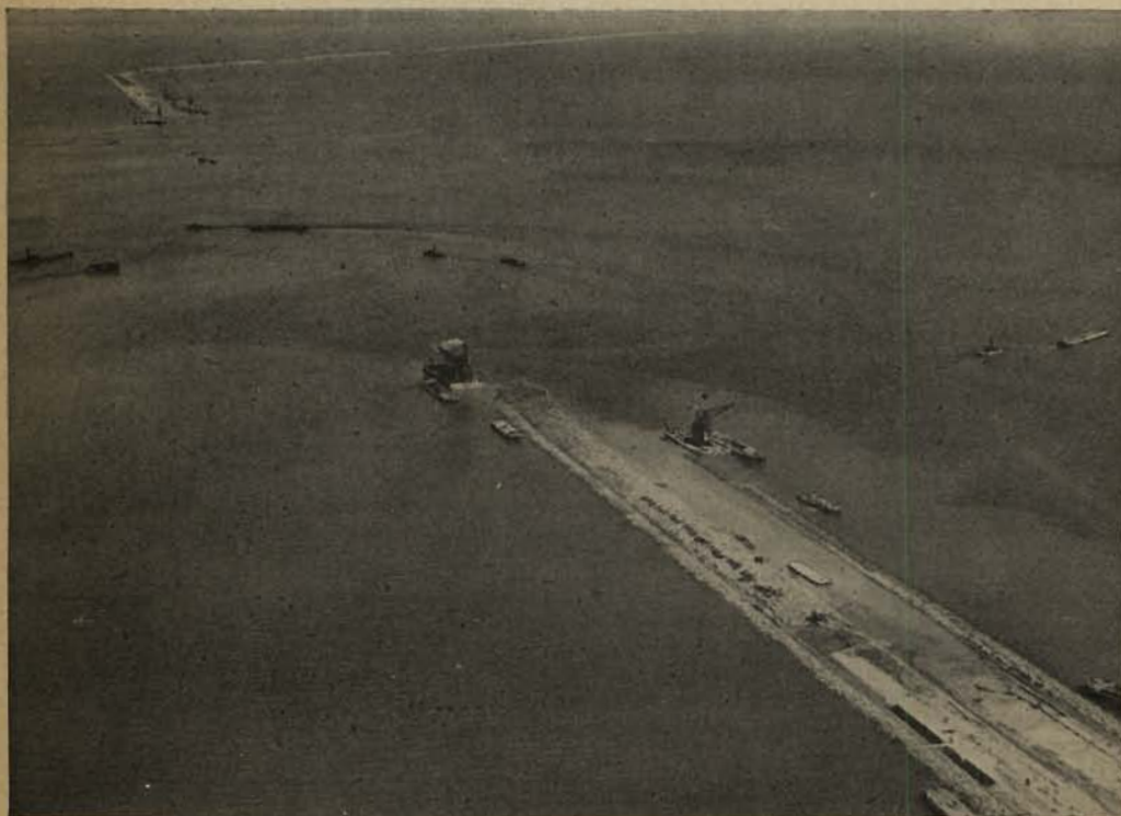
Opening in het dijkvak Lemmer-Urk (10 Aug. 1939) Luchtfoto K. L. M.
