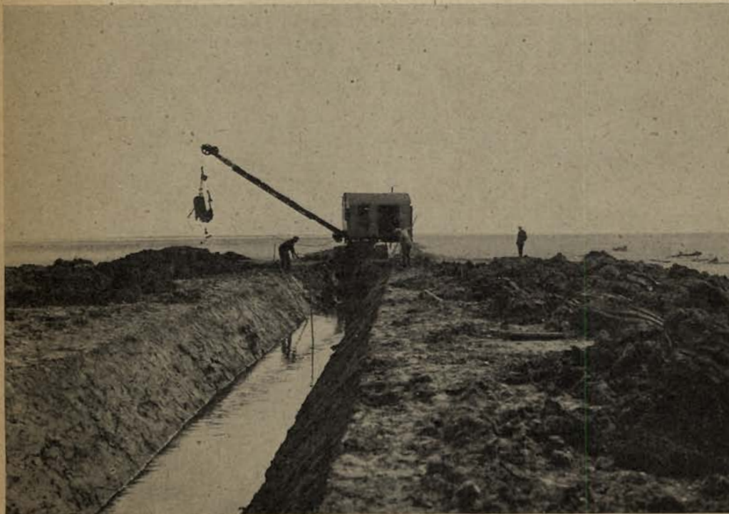
Het graven van een kavelsloot door middel van een dragline
