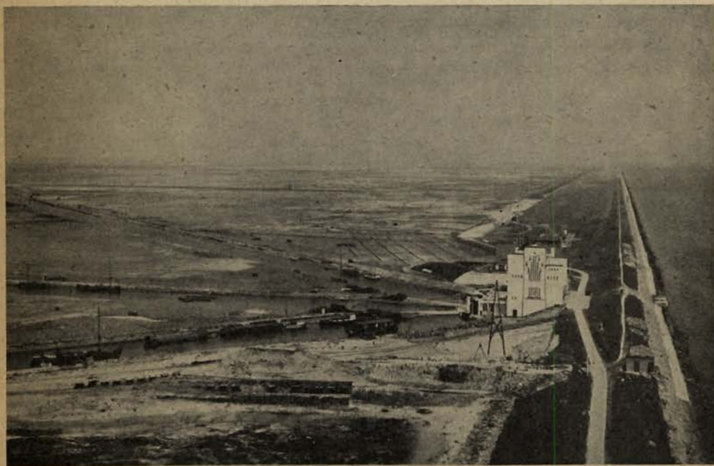
Gemaal Lely, met overzicht van de drooggevallen gronden in de Wieringermeer 1931
