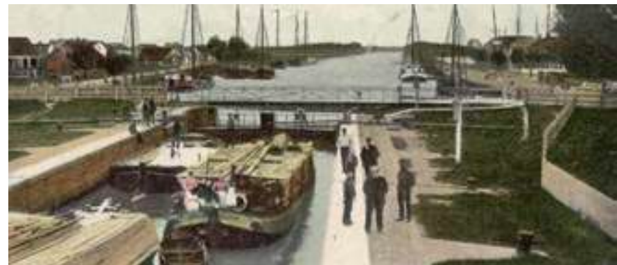
Eemskanaal (1905) Bron: Rijkswaterstaat, de KIJK
