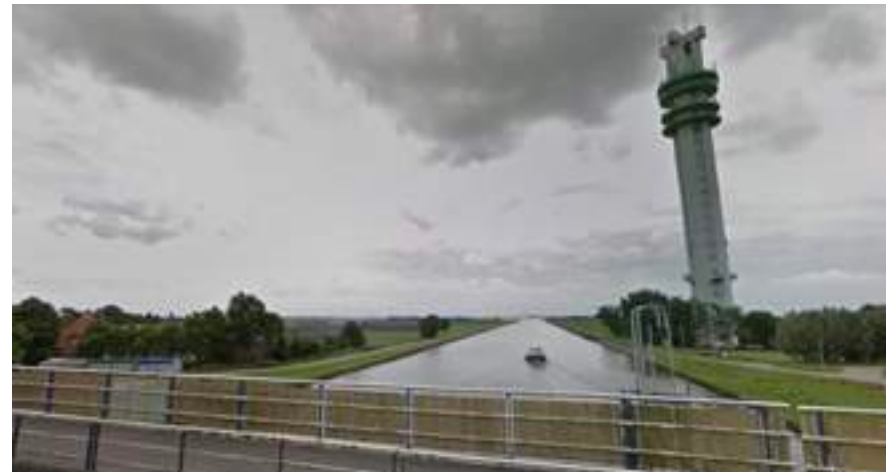
Zicht vanaf de brug op het kanaal en de toren Spannenburg Bron: Cyclomedia
