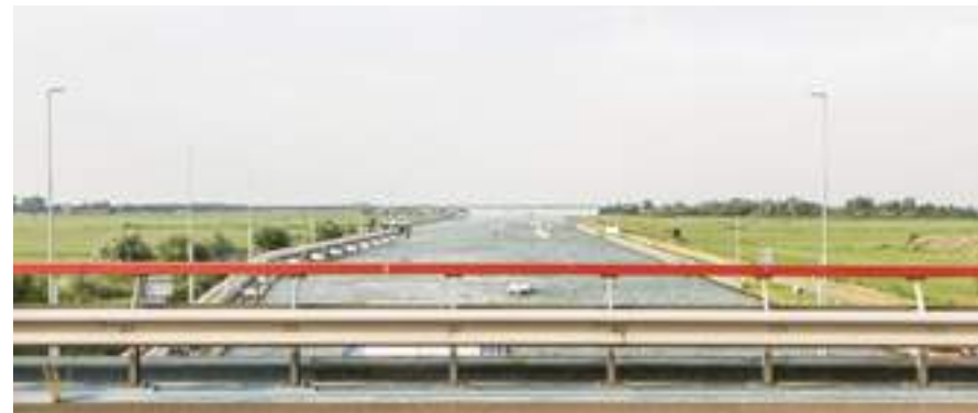
Gegraven kanaaldeel van het Prinses Margrietkanaal als verbinding tussen de meren.
