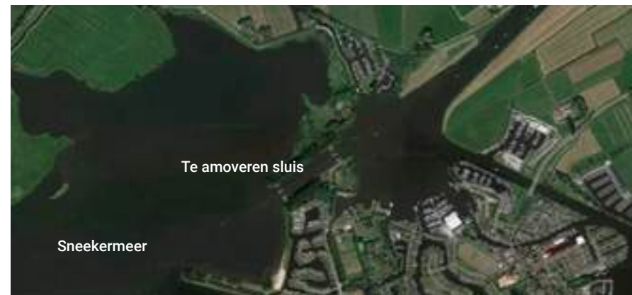
Sluis Terherne Bron bovenstaande afbeeldingen: Cyclomedia
