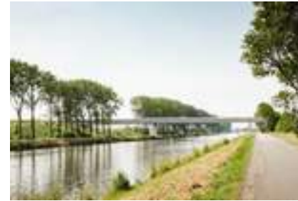
1. Hoge vaste bruggen en bascule bruggen
