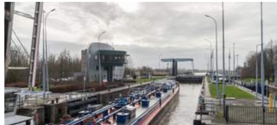
Sluiscomplex zeesluis Farmsum Bron: Rijkswaterstaat
