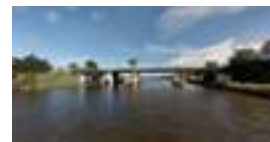
Brug Oude Schouw
