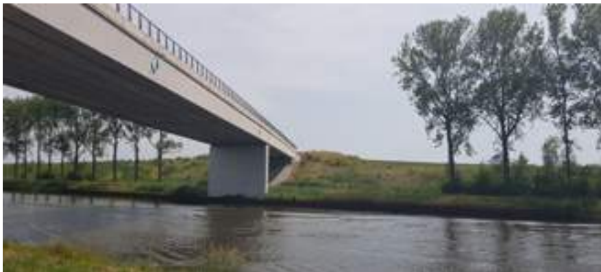
De hoge vaste brug bij Zuidhorn Bron: NEXT architects
