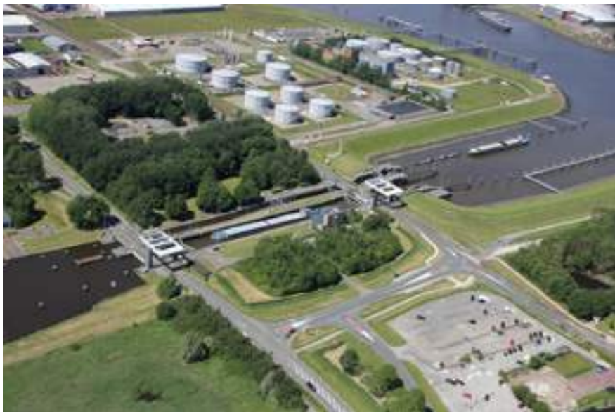
Sluiscomplex zeesluis Farmsum Bron: Rijkswaterstaat
