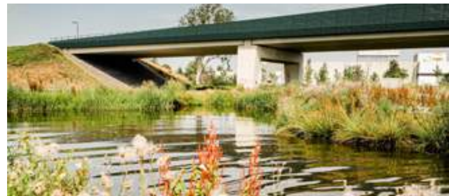
Bij brug Burgermerdaam is naast aanleg van een nieuwe brug ook ingezet op natuurontwikkeling en sluit het beeld goed aan op het merenlandschap Bron: H+N+S Landschapsarchitecten
