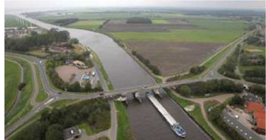
Luchtfoto brug, zicht richting het zuiden Bron: geoservices.rijkswaterstaat.nl
