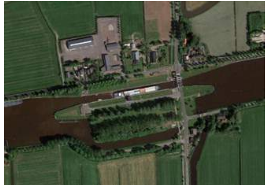
Luchtfoto sluiscomplex Gaarkeuken Bron: Cyclomedia
