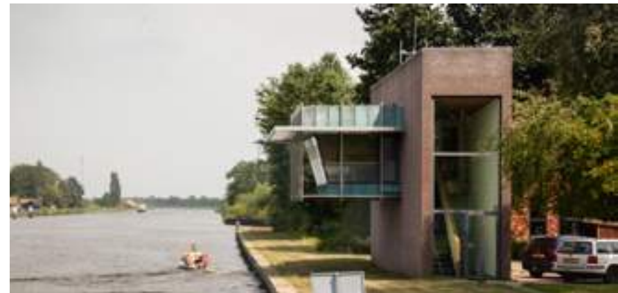
Bedieningsgebouw als landmark langs de HLD Bron: H+N+S Landschapsarchitecten, Tim Kort
