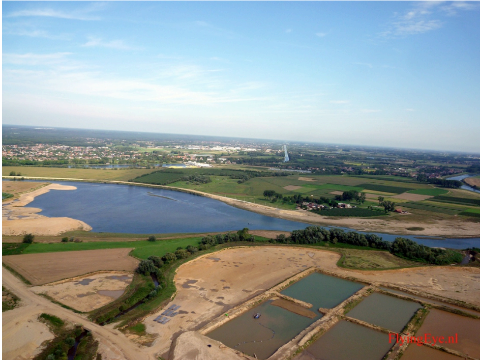
Foto 2.1: De weerdverlaging bij de Itterense weerd in de Grensmaas pakte, mede door de benedenstrooms gelegen drempel, anders uit dan in het oorspronkelijke ontwerp beoogd was: er ontstond een grote watervlakte in plaats van een reliëfrijke oever (links boven). Voor deel twee van de uitvoering is dan ook een aangepast ontwerp gemaakt (foto: Consortium Grensmaas).
