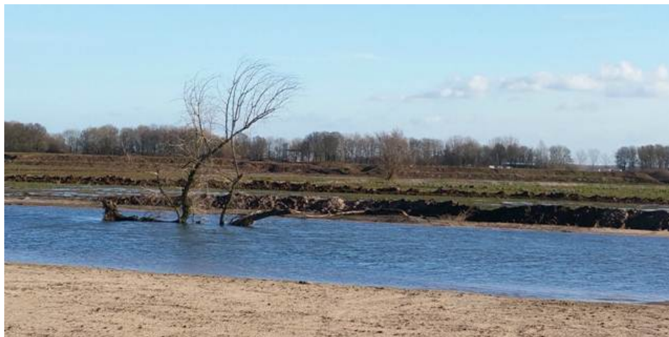
Foto 2.3: Het aanbrengen van rivierhout in de vorm van bomen (met kruin en wortels) in de rivier of in geulen of plassen, verhoogt het ecologisch rendement van de maatregelen (foto Rijkswaterstaat).
