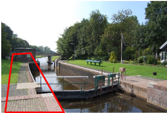
Figuur 7: Sluis met stenen wanden
