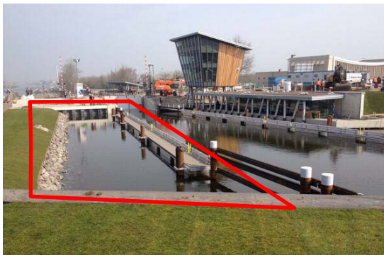
Figuur 8: Groene kolk met taluds
